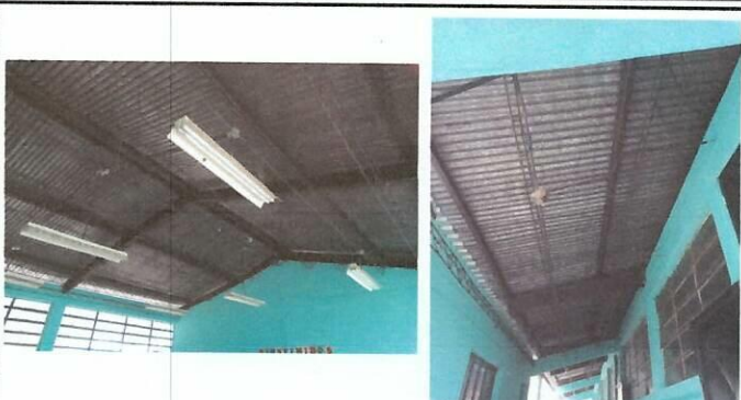
Foto 2: Cambio de lámparas que están fuera de funcionamiento, mejoras en instalación eléctrica.
