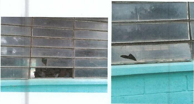
Foto 3: Instalación de vidrios quebrados en ventanas.
