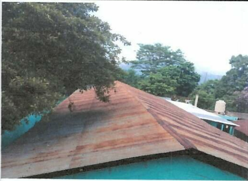
Foto1: Desmontaje de láminas antiguas, Pintado de Vigas de 8x4x6 y Costaneras de 2x4x 26mt, Instalación de Lamina Troquelada Calibre 26 de 1mt útil.
